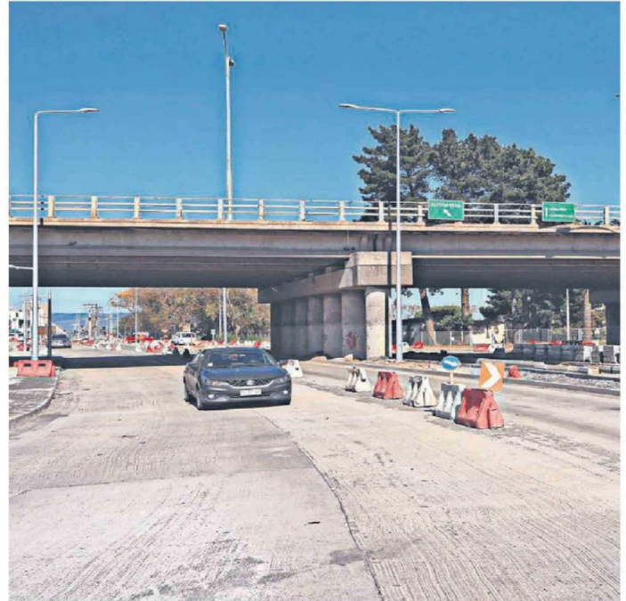
La obra se reactivó en marzo de 2024, tras más de un año sin avance por el quiebre de la exconstructora.
