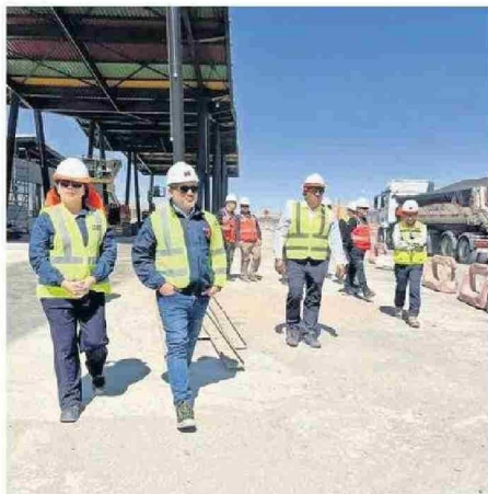
AUTORIDADES LOCALES INSPECCIONARON LA OBRA.
