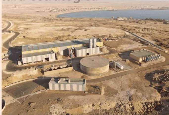
Planta Desaladora de Nueva Atacama en Caldera.
