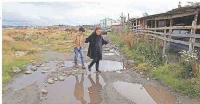
Las últimas lluvias, sumadas a la acumulación de aguas servidas, han transformado algunos caminos de la toma en verdaderos pantanos.
