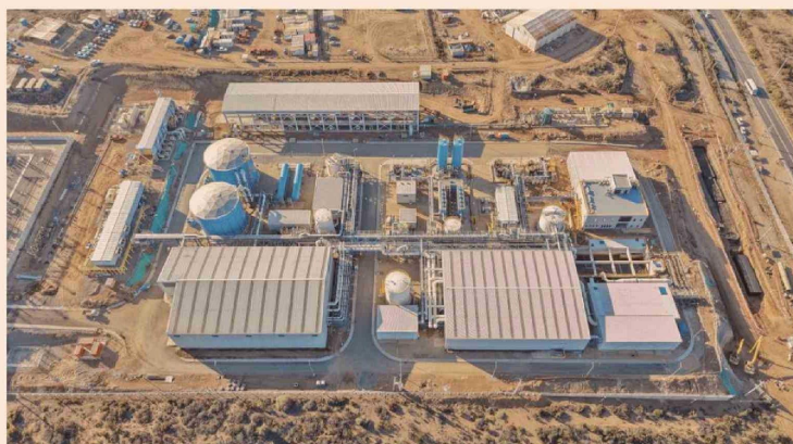
Planta Aguas Pacífico.
