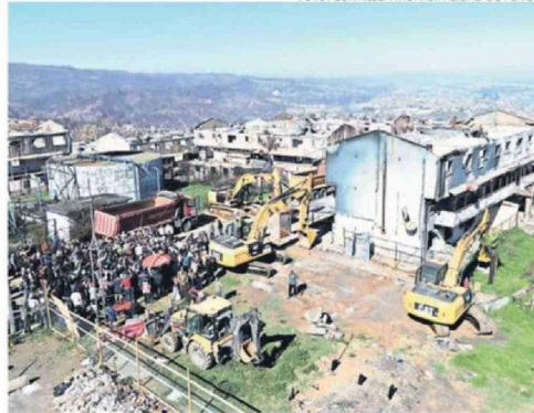
INICIO DEL PROCESO DE DEMOLICIÓN DE LOS EDIFICIOS.
