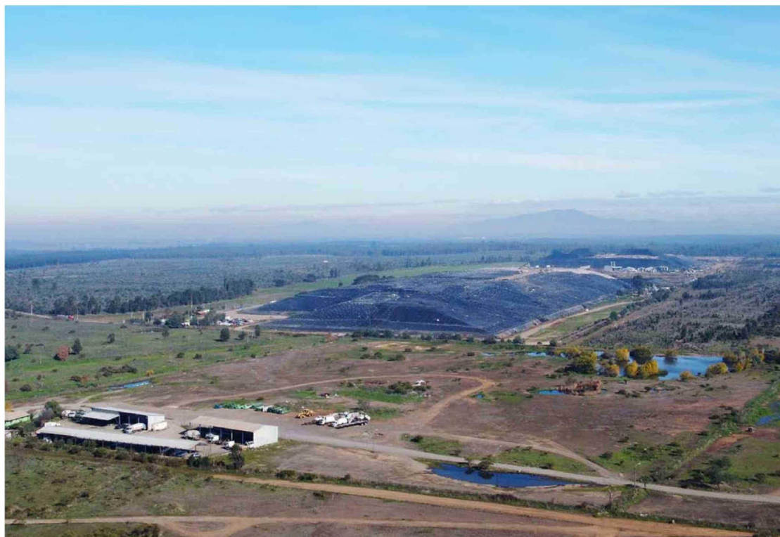
El proyecto se emplazará en el lugar donde operó el relleno Quilmo, de Enasa.
