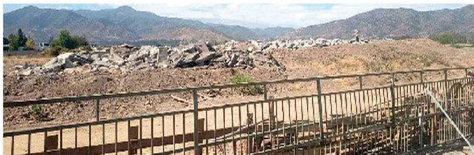
Vecinos acusaron la existencia de un centro de acopio irregular de residuos de construcción.
