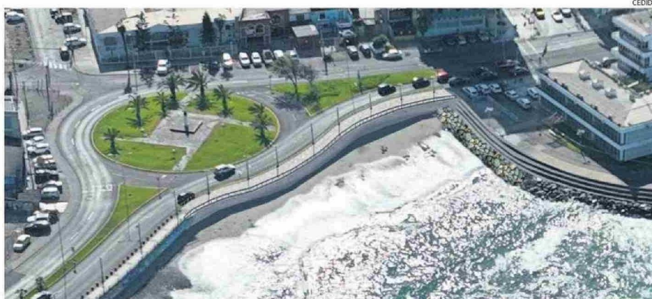
EL CORTE SE EFECTUARÁ A MEDIADOS DE JULIO, ENTRE EL EDIFICIO BELLAVISTA Y EL COSTADO NORTE DEL GOBIERNO REGIONAL
