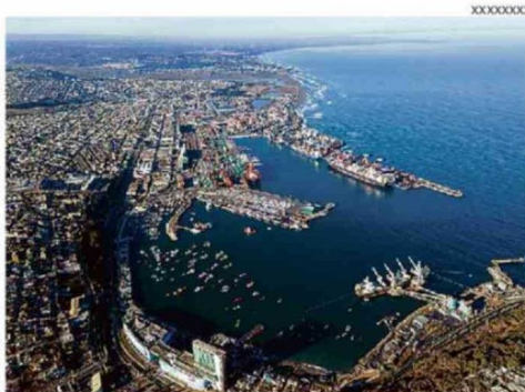
DESDE EPSA DESTACARON EL AVANCE DE LA INFRAESTRUCTURA.
