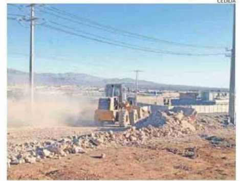
LOS ARREGLOS SE EFECTUARON EN CERCA DE 5 KILÓMETROS DE CAMINO.
