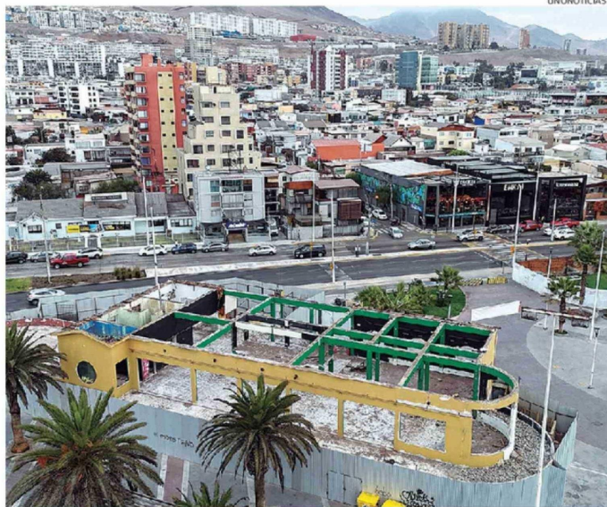
EDIFICIO SE ENCUENTRA SIN USO DESDE HACE MUCHO TIEMPO.
