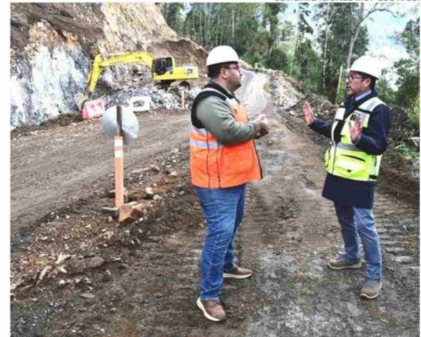
EL SEREMI DEL MOP REALIZÓ UNA VISITA INSPECTIVA A LOS TRABAJOS.
