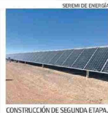
CONSTRUCCIÓN DE SEGUNDA ETAPA.
