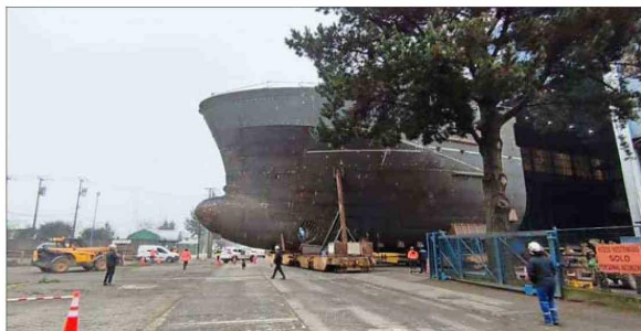
EN CONSTRUCCIÓN. — Parte de la embarcación cruzó la avenida España, entre las plantas de Asenav, en Valdivia.
