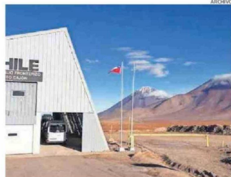
HITO CAJÓN SE UBICA EN LA RUTA 27CH EN LA COMUNA DE SAN PEDRO.
