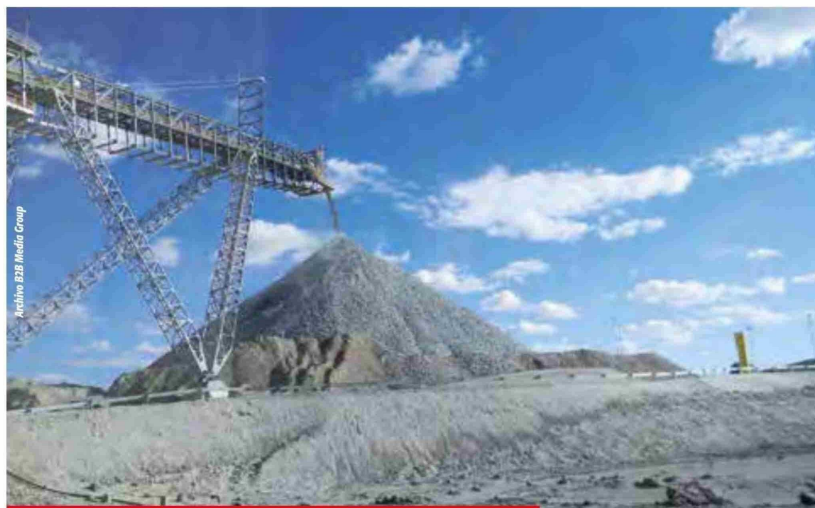
Las correas transportadoras utilizan tecnología avanzada para mantenimiento predictivo y optimización de la operación.
