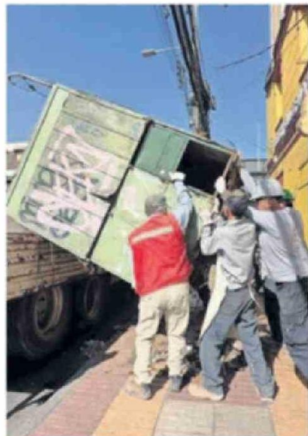
ESTABA EN CALLE LATORRE.
