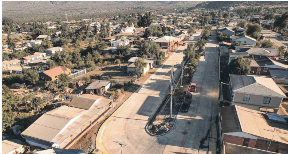
La ejecución de las obras de alcantarillado de Caimanes en Los Vilos comenzó oficialmente en 2024, tras 20 años de espera. LOS PELAMBRES
