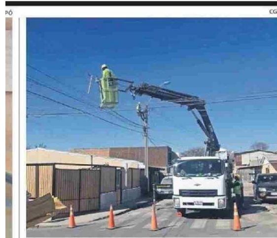
EQUIPO TRABAJANDO EN TERRENO.
