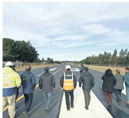
Las obras se encuentran en su etapa de finalización.
