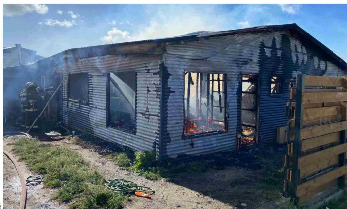
El fuego destruyó íntegramente la vivienda de un piso, cerca del mediodía de ayer, dejando al menos a dos personas damnificadas.
