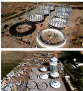
Obras en la planta de AgriChile ubicada en el Fundo Caracas, en la comuna de Curico.
