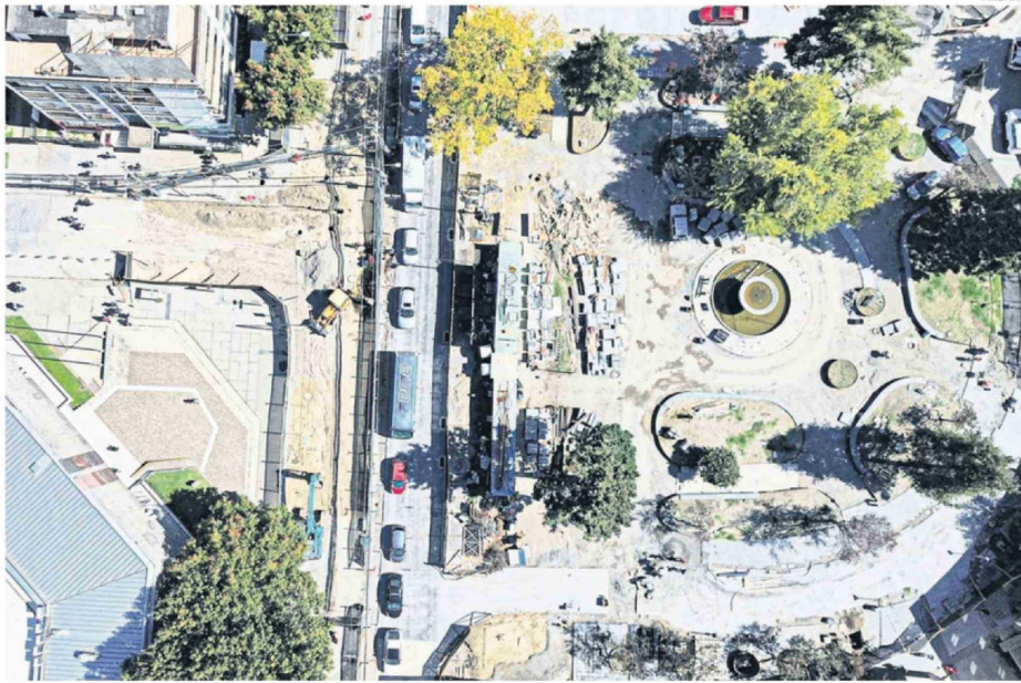
LAS OBRAS DE REMODELACIÓN DE LA PLAZA PERÚ SE INICIARON EN JUNIO DEL AÑO PASADO Y HAN TENIDO UNA SERIE DE RETRASOS.
