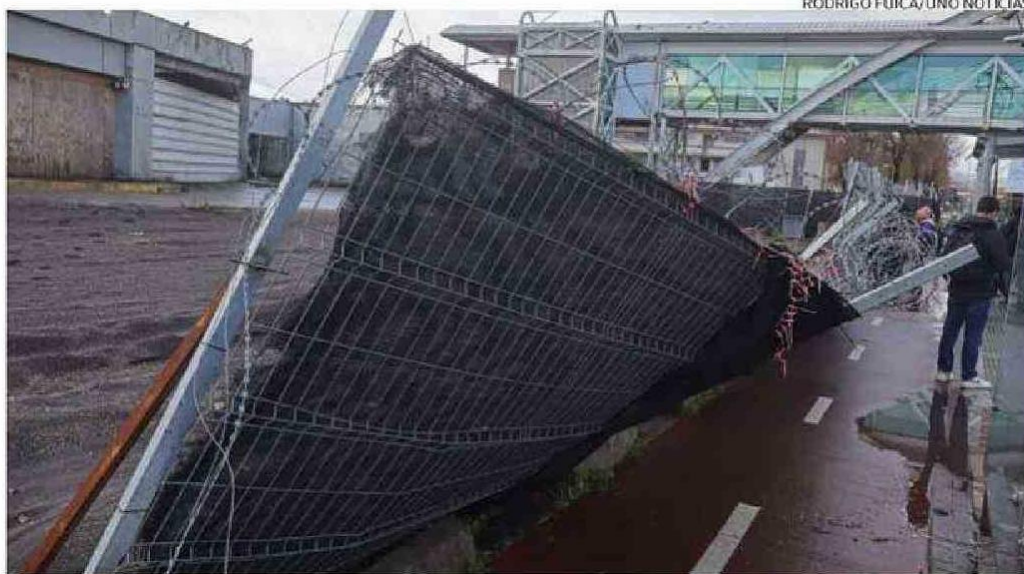
El sistema frontal afectó al suministro eléctrico y dañó estructuras y viviendas en el Biobío.
