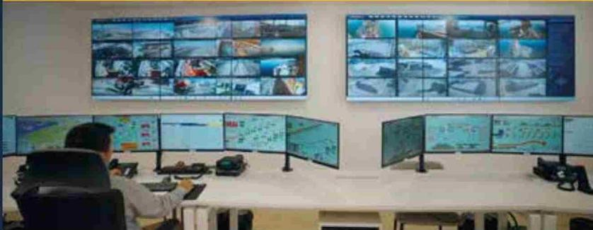
control que existían de manera independiente en una sola unidad centralizada, donde supervisan en tiempo real las operaciones de descarga, almacenamiento y despacho de ácido sulfúrico tanto por tren como por camión, así como la recepción, acopio y transferencia de graneles sólidos como los concentrados de mineral, clinker o azufre.
