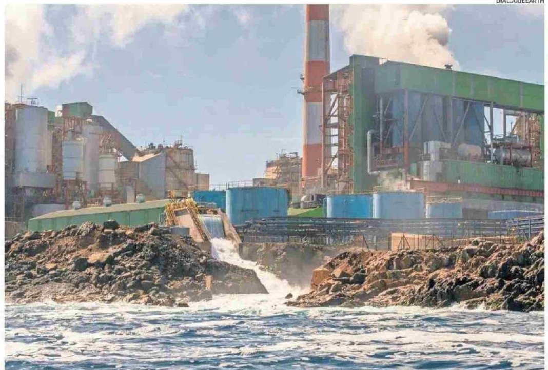
EL AGUA UTILIZADA PARA LA REFRIGERACIÓN POR EL COMPLEJO ENERGÉTICO DE GUACOLDA SE DEVUELVE AL MAR.
