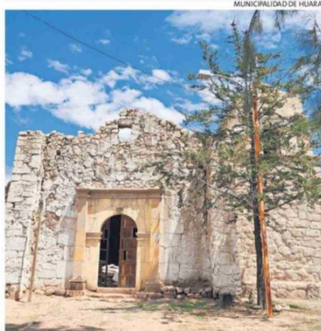
PROYECTAN QUE LAS OBRAS CONCLUYAN EN SEPTIEMBRE DE ESTE AÑO.
