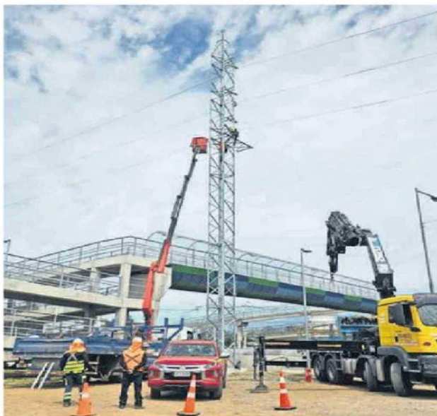
Las obras permitirán una mejor distribución de la electricidad.
