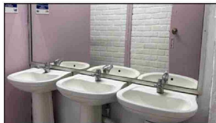
Trabajo de mejoramiento en baños.
