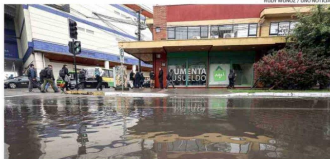
LA CALLE ILLAPEL CON EGAÑA TERMINÓ EN ESTAS CONDICIONES, YA QUE EL AGUA NO FILTRÓ POR EL SUMIDERO.
