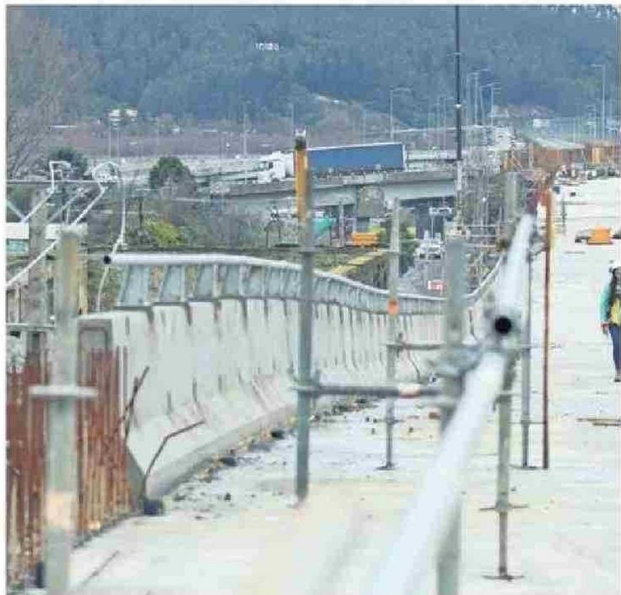
Faenas se concentran en la conexión con Chacabuco.
