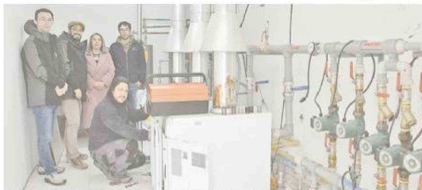
Obras de mantención de una caldera en uno de los establecimiento de Junji Magallanes.
