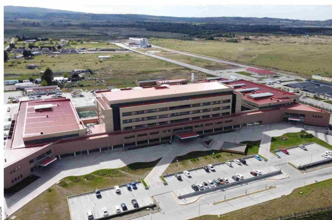
El equipo será instalado en el Hospital Clínico Magallanes.
