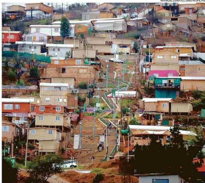
DAMNIFICADOS DEL MEGAINCENDIO DENUNCIAN FILTRACIONES EN SUS VIVIENDAS.
