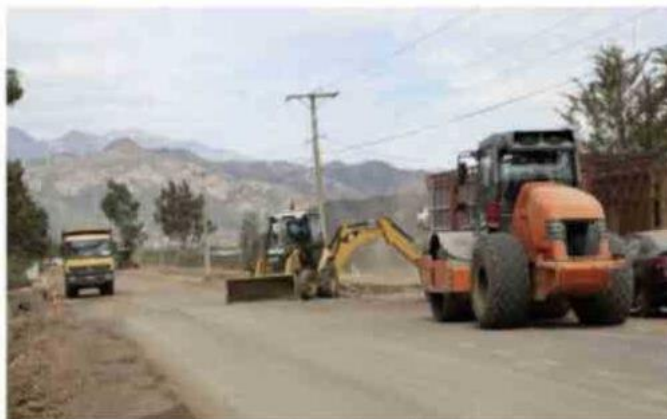
→ Mejoramiento Ruta I-45 sector Puente Negro-La Rufina
