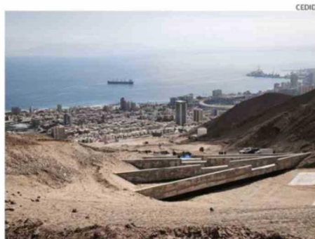
NUEVA INFRAESTRUCTURA REFORZARÁ SEGURIDAD ALUVIONAL.
