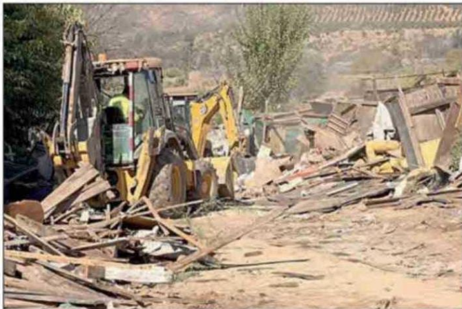
Se retiraron 164 toneladas de basura y escombros durante el procedimiento.
