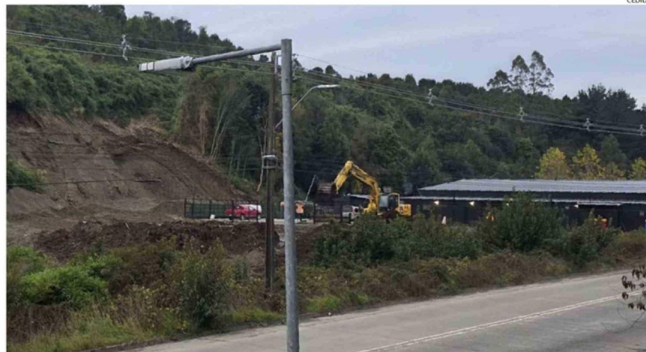
ESTE ES EL PUNTO DE LAS FAENAS EN CALLE REGIMIENTO. UNA PROPIEDAD VECINA REGISTRA INUNDACIONES, SEGÚN DENUNCIÓ GAYI.
