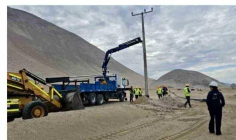
reconstruir los tramos compro- metidos y dejar nuevamente operativa la infraestructura de distribución, en un proceso que requiere etapas sucesivas de instalación, ajuste y control técnico antes de proceder a la energiza- ción del sistema.
