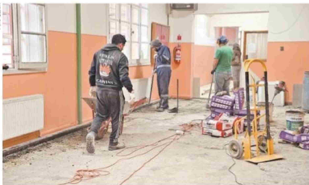
Los trabajos que se vienen ejecutando en la Escuela República de Croacia.
