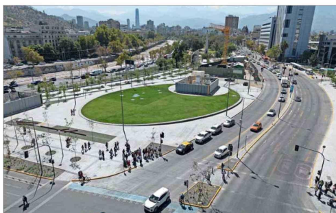
La inauguración también incluyó dos de tres tramos de la ciclovía Nueva Alameda, impulsado por el Gobierno Regional.
