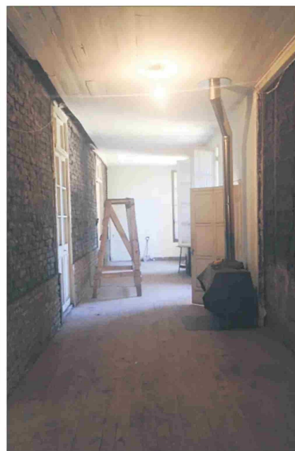
La casona era un gran espacio de 1.500 metros inutilizados.
