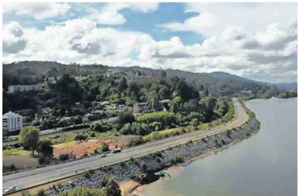
El proyecto representa la tercera etapa de ampliación de la Costanera.
