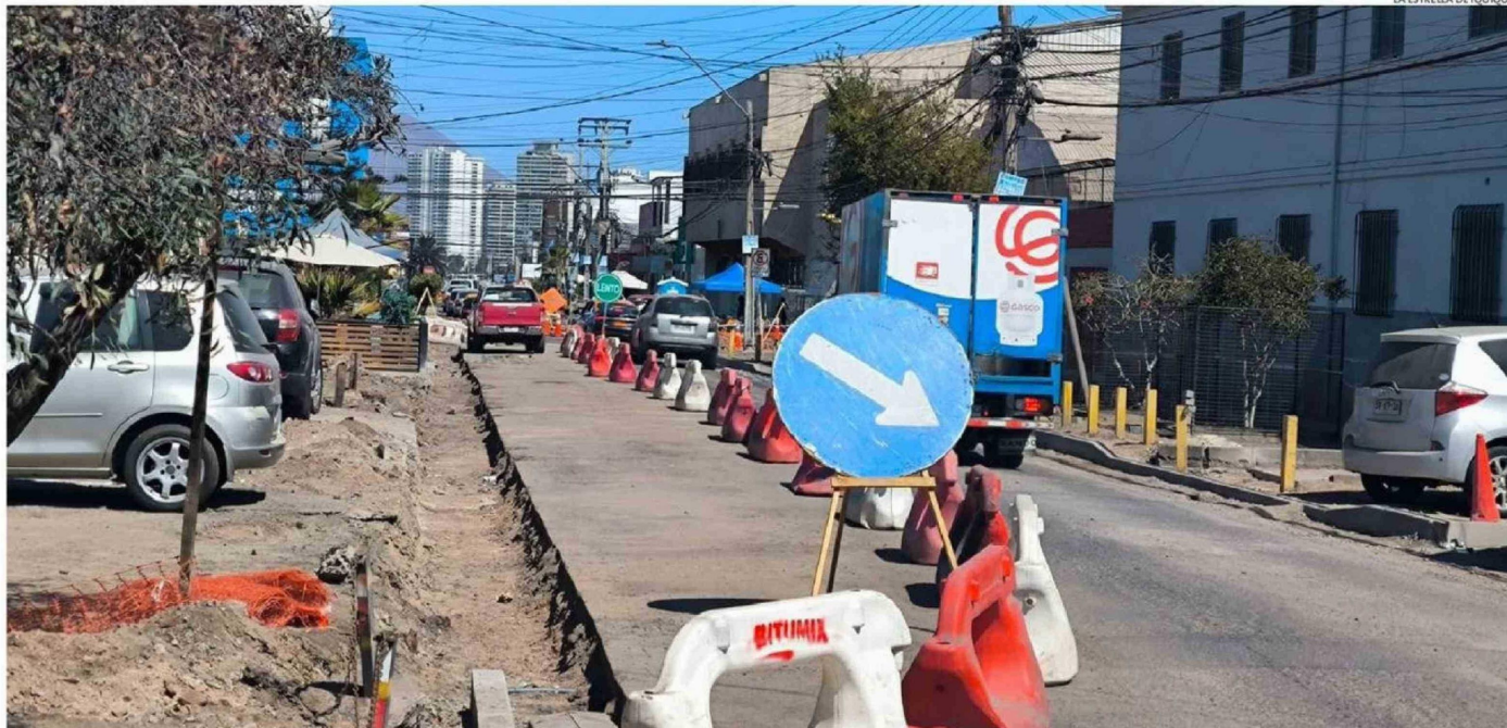
ACTUALMENTE SE EJECUTAN TRABAJOS EN EL SECTOR DE CALLE BARROS ARANA ENTRE RIQUELME Y JOSÉ JOAQUÍN PÉREZ.
