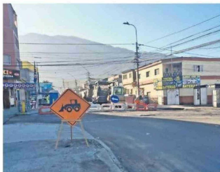
EN ZEGERS CON 18 DE SEPTIEMBRE TAMBIÉN SE EJECUTAN OBRAS.
