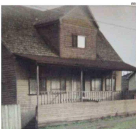
CASA DE LA FAMILIA HINOJOSA GALLARDO EN RAHUE (DEMOLIDA).
