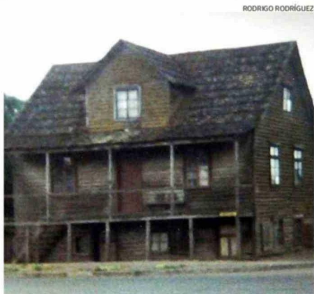
CASONA CON CORREDOR Y ZÓCALO EN CALLE CONCEPCIÓN (DEMOLIDA).
