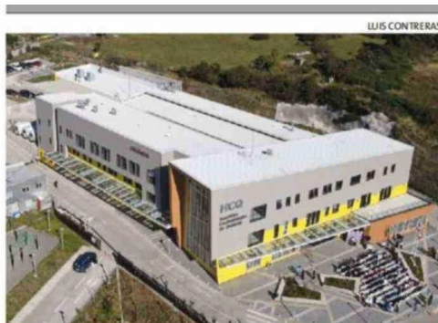
VISTA AÉREA DEL NUEVO ESTABLECIMIENTO ASISTENCIAL QUEILINO.
