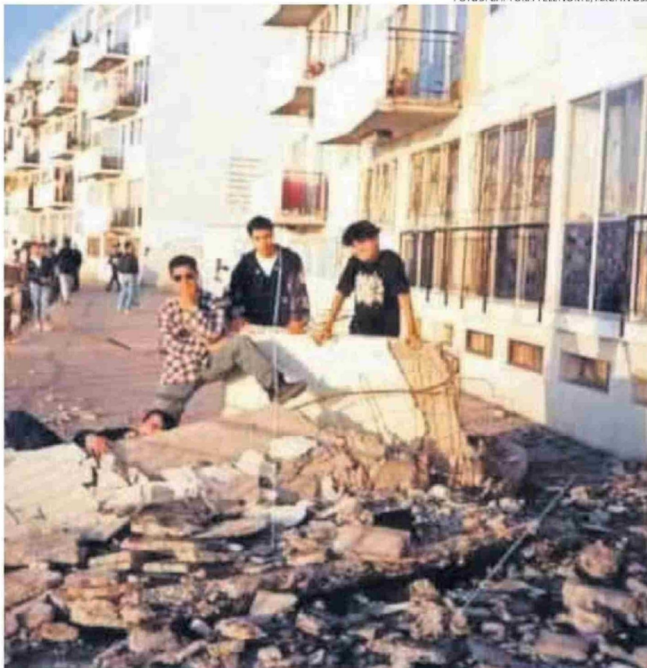
EN LOS EDIFICIOS DEL CURVO Y EL CALICHE SE REGISTRARON GRANDES DAÑOS ESTRUCTURALES, LOS CUALES FUERON SUBSANADOS AL POCO TIEMPO.
