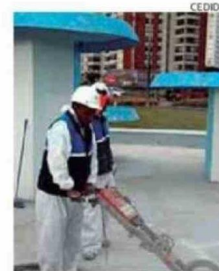
TRABAJOS EN PILETA SECTOR SUR.
