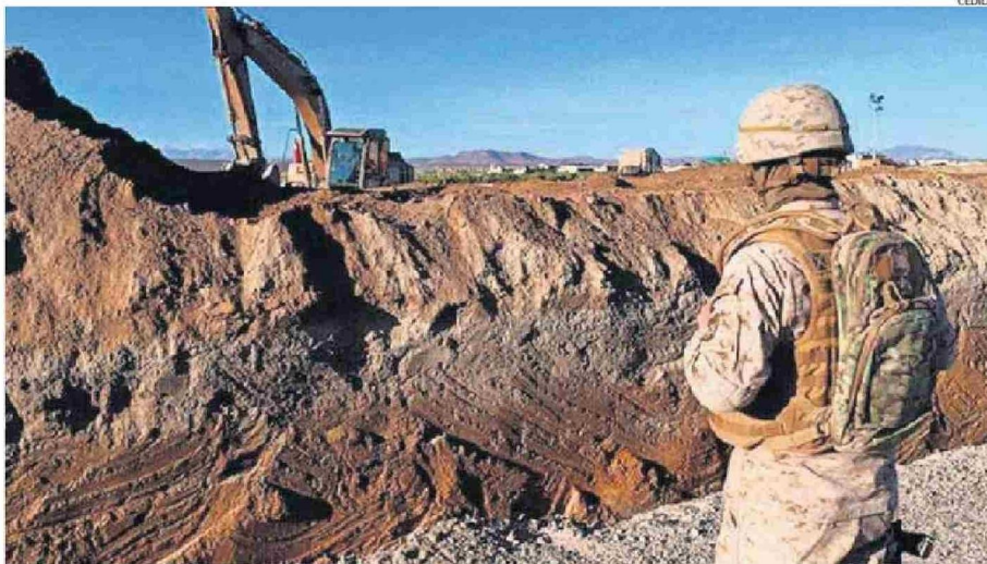
LAS OBRAS DEL PLAN ESCUDO FRONTERIZO COMENZARÁN ESTE LUNES.
